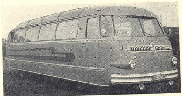
Bild 4. Omnibus mit Heckmotor und selbsttragendem Aufbau (Ford-NWF)
